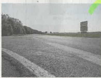
Die B-16-Anschlussstelle Peterswörth soll ausgebaut werden. Archivfoto: Paul
