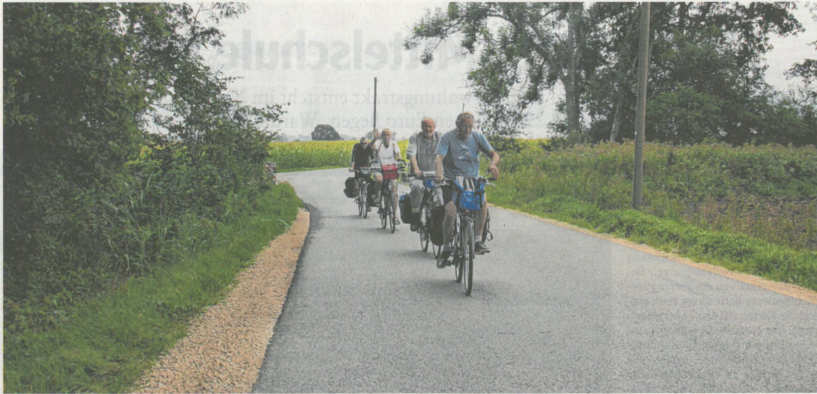
Dies Bild auf dem Weg von Pfaffenhofen nach Donaumünster gehört bald der Vergangenheit an: Für Radfahrer, Fußgänger und Landwirtschaft wird ein eigener Anwandweg gebaut, die Fahrbahn auf sechs Meter verbreitert. Foto: Hertha Stauch
